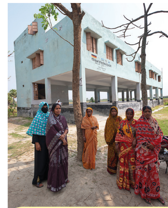
Am 8. März 2012 präsentierten Frauen aus dem Dorf Rajeswar in Bangladesch ein auf einem Sockel gebautes Betonhaus. In diesem „Cyclone Shelter“ können die Bewohner des Dorfes bei Überschwemmungen Zuflucht suchen. Bauherr ist die einheimische NGO Nabolok, eine Partnerorganisation von „Brot für die Welt“.
